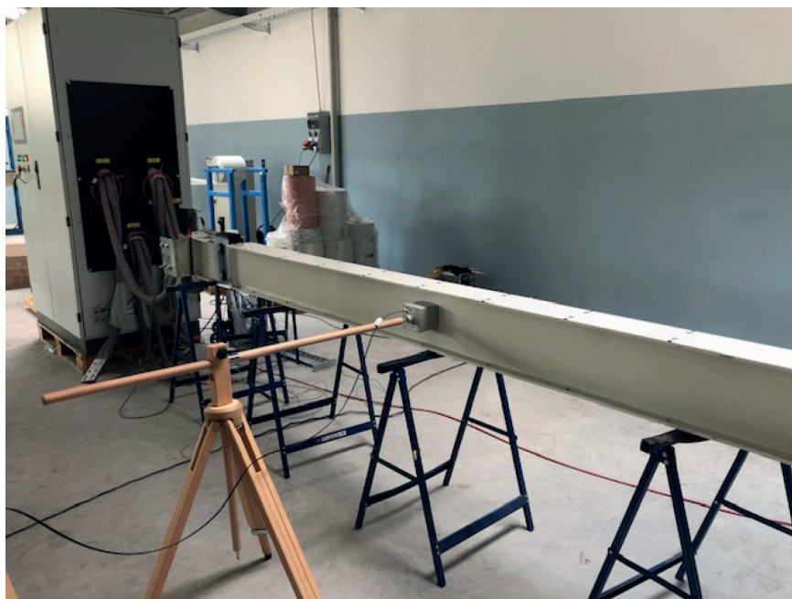
Fig. 3 Posizione sonda per misura induzione magnetica lungo il condotto sbarre
