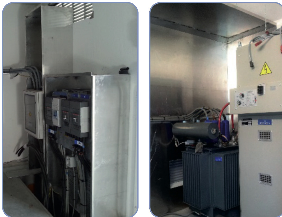
Fig. 22 - Installazione elementi schermanti
