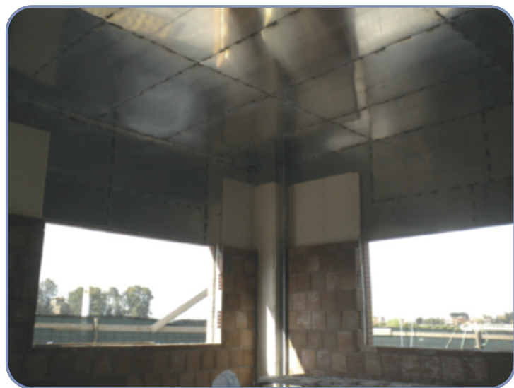
Fig. 11 - Installazione della schermatura
