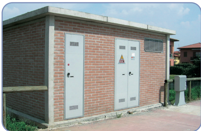
Fig. 20 - Cabina di trasformazione secondaria
